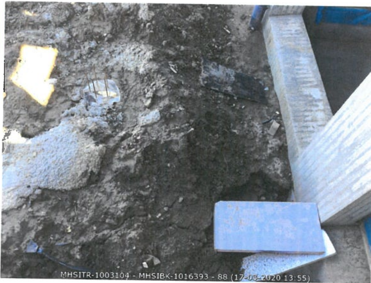
Palen geboord voor aanleg toekomstig zwembad. Boorgegevens nu niet noodzakelijk
